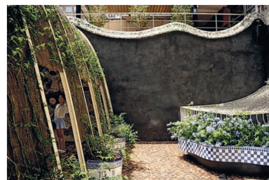
波浪狀的圍牆讓人有置身大自然之感。牆身修復後呈現其原始色彩，牆中央的一段破碎磚塊牆體 (圖左)，經歷史照片比對，確認為原先懸鏈拱結構的位置。(法新社)
