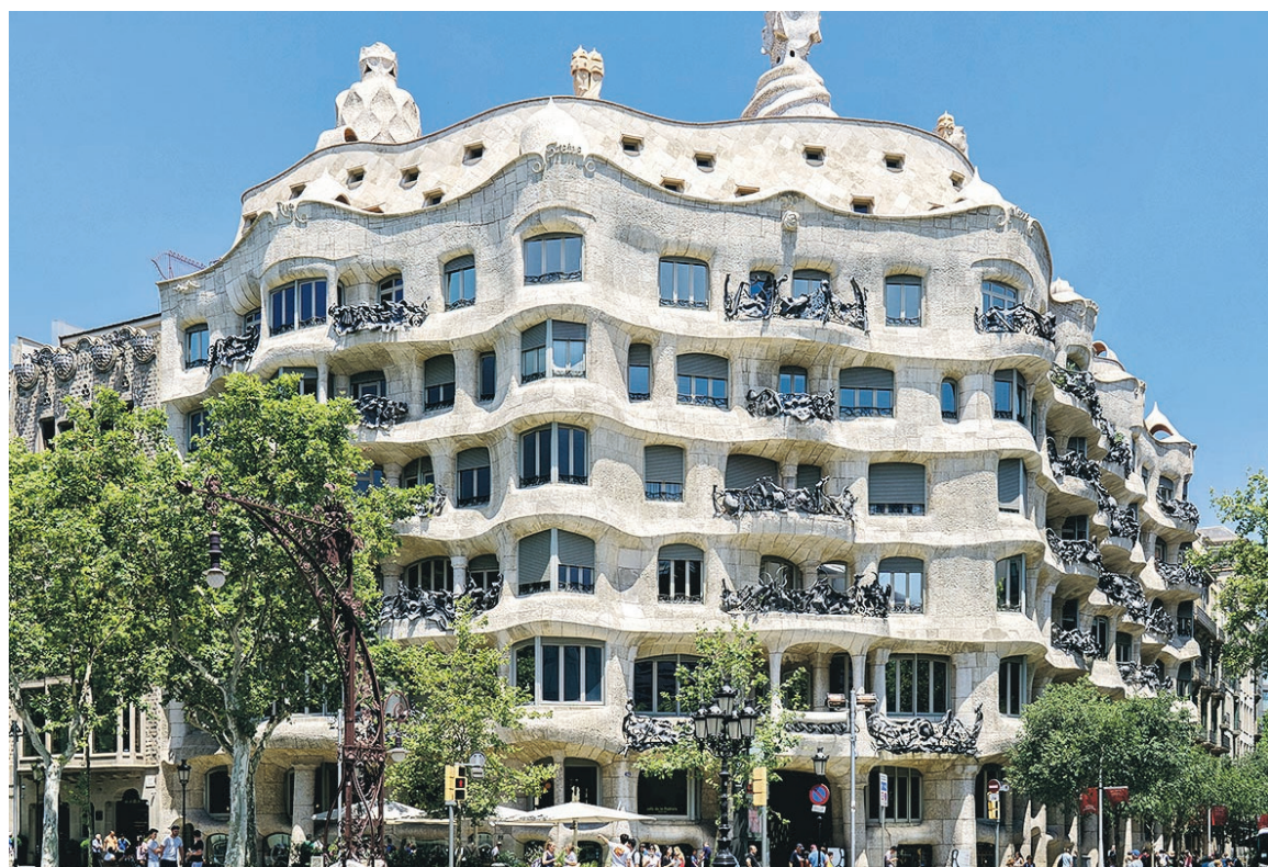
高第另一項傑作——跟巴特略之家僅隔三街的米拉之家，其波浪形屋頂其實也依靠大型懸鏈拱骨架构作為支撐。（Thomas Ledl@Wikimedia Commons）
