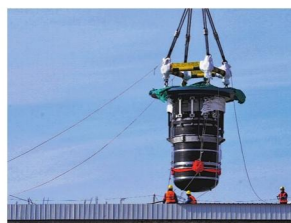
钍基熔盐实验堆本体在进行吊装。（上海应用物理研究所）
