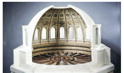
圖為圓頂閱覽室的原設計模型。時任大英博物館圖書館館長帕尼齊較鍾情羅馬萬神殿一樣的圓頂結構，於是堅持大穹頂設計。他亦命建築師參考由英國哲學家邊沁提出的環形監獄概念，令書架可從圓心放射擺放，並將圖書管理員的位置擺放在中央。（V&A博物館官網圖片）
