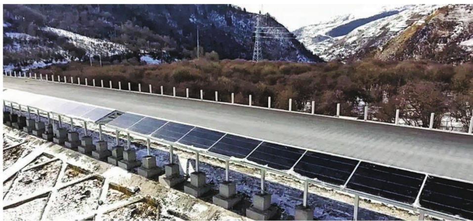
连接青海久治县与四川马尔康市的久马高速，技术团队在路旁构建发电玻璃，供电路面「自发热」融雪。（四川省交通宣传中心）
